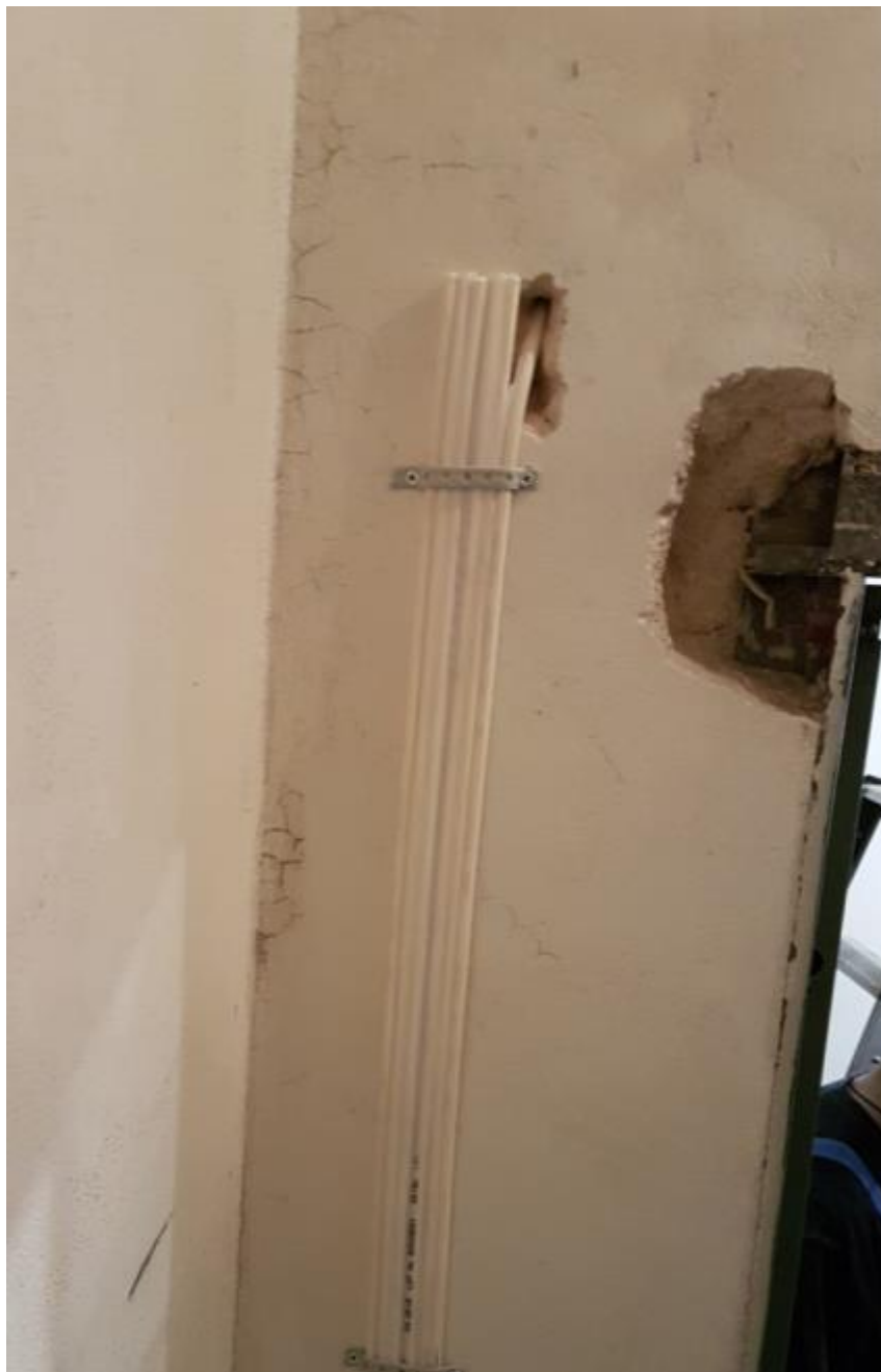
Σχήμα 10. Έξοδος σωληνίσκου (πλευρά φρεατίου)
