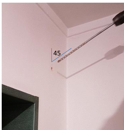
Σχήμα 4. Ξετρύπημα από τον διάδρομο προς το φρεάτιο
