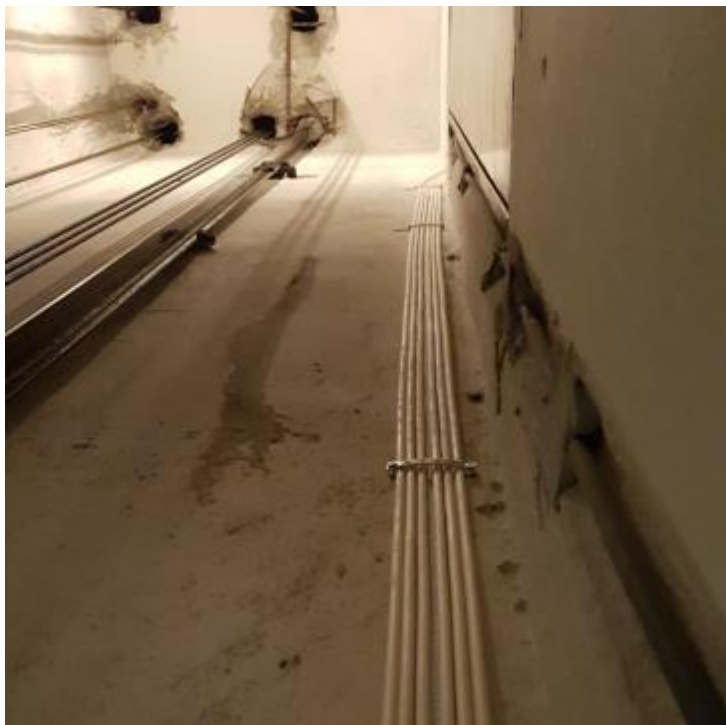
Σχήμα 7. Στήριξη πολυσωληνίου ανά 1m.
